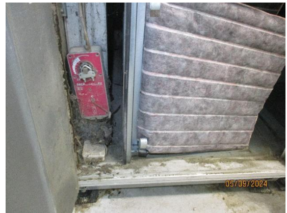
Kuva 8.4 TK04 sisäpinnat hyvin likaiset (imeytyntä ja pinttynyttä likaa)
