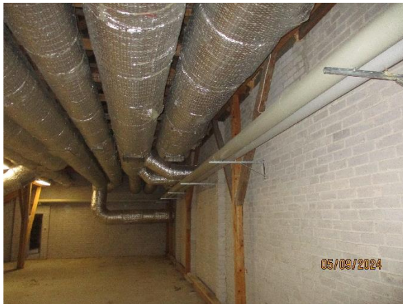
Kuva 8.9 Ullakko-tilassa kulkevat kanavistot ovat eristetty
