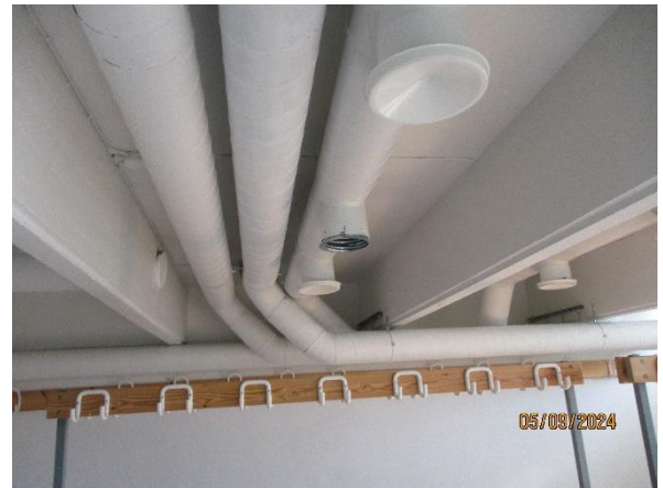
Kuva 8.10 Kellarin pukuhuonetilassa näkyvillä olevat kanavat
