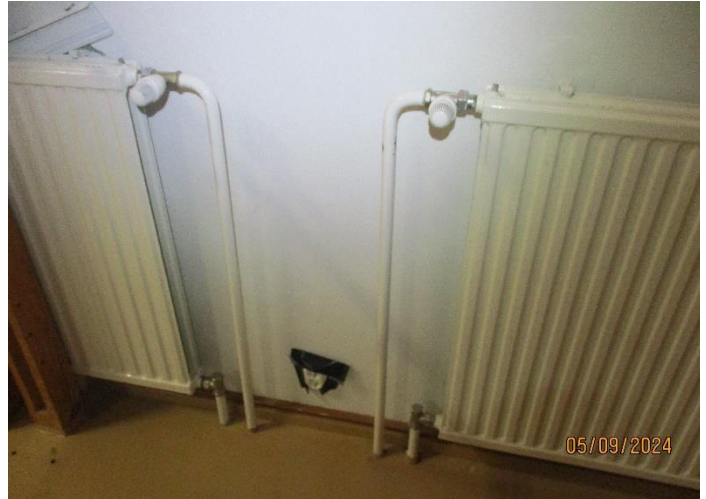
Kuva 5.14 Liikuntasalin teräslevypattereita.
