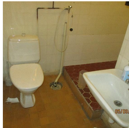
Kuva 6.15 1 kerroksen A-osalla vanhempia kalusteita yhä käytössä.
