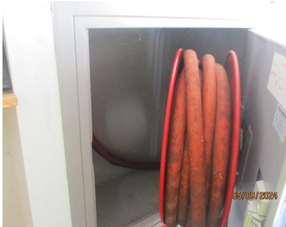
Kuva 6.16 Pikapaloposteilta ei löytynyt tarkastusmerkintöjä. Asennusvuosi 1997.
