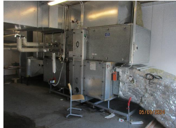
Kuva 8.2 TK03 IV-kone luokkahuoneet vuodelta 1998
