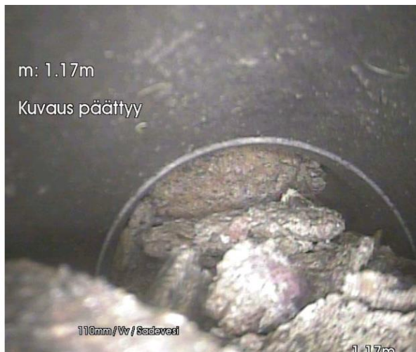
Kuva 7.7 Sadeveden viemäriin jassa kiviä. (Kuvaus SVTK1).
