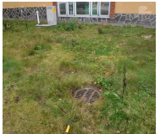
Kuva 7.2 Maanpinta on tasaista, viettä kaivoihin on nimellisesti, tai ei ollenkaan.
