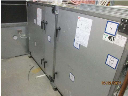
Kuva 8.1 TK01 kellarin luokkatiloja palveleva IV-kone vuodelta 2010, kone seis (puhallin rikki).
