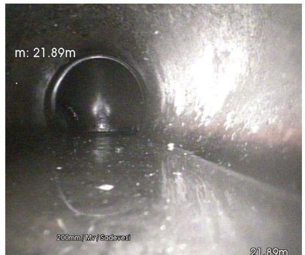
Kuva 7.8 Sadeveden viemäriin joissa paikallisia painumia. (Kuvaus SVK1).
